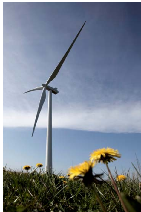
Figure 5 : photo d'une éolienne V110 [source : Vestas]
