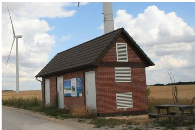
Illustration 1 : poste de livraison existant au bord de la RD94
