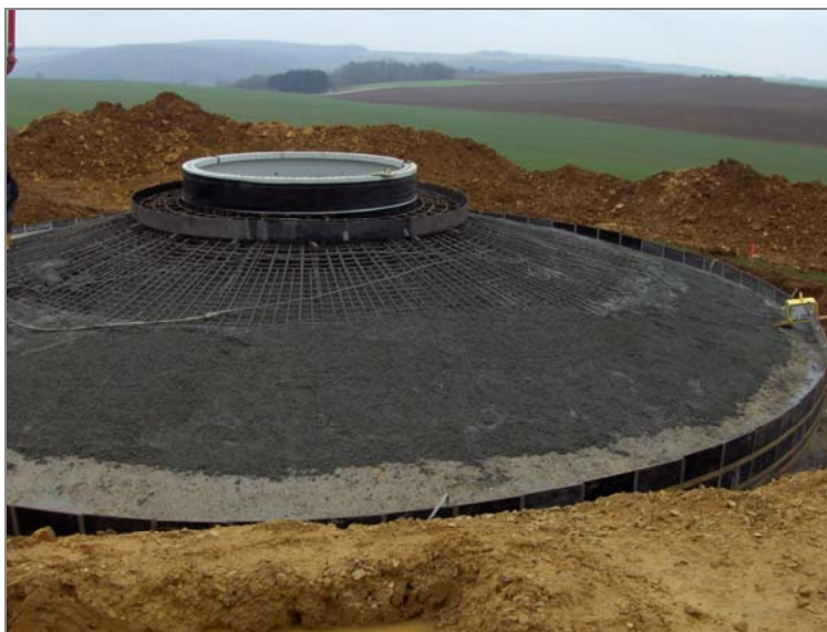
Exemple de ferrailage en radier pour une éolienne
